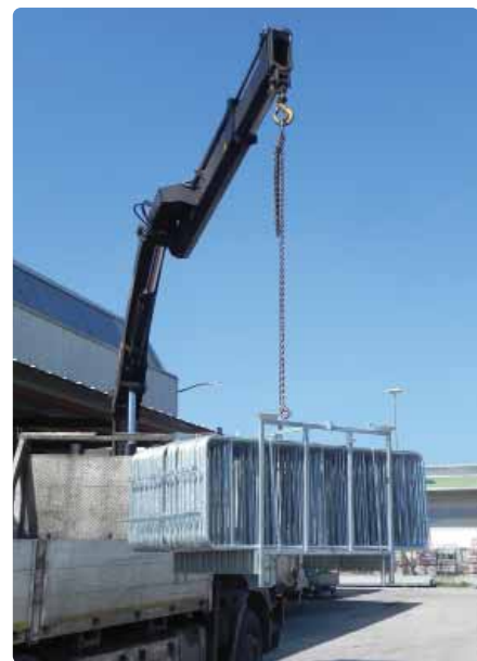
Carico e scarico con gru su automezzo
