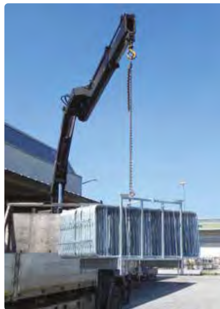
Carico e scarico con gru su automezzo
